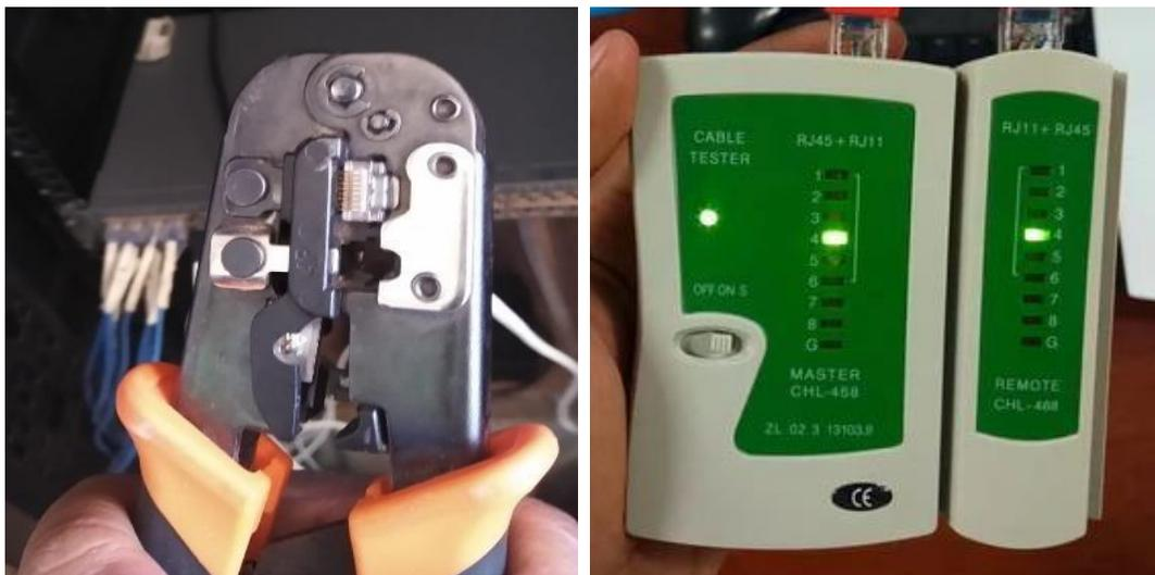
**Figura 7. Armado y prueba de cable Ethernet**
