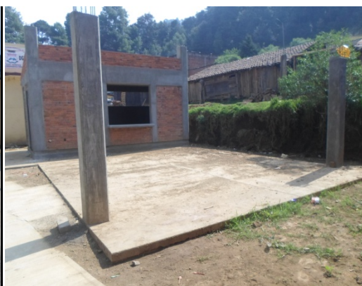
Figura 2. Construcción del comedor
