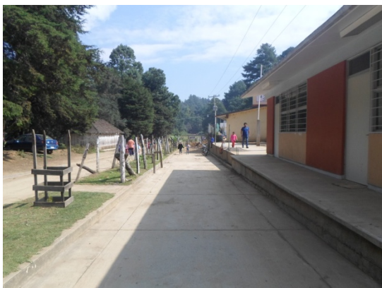
Figura 3. Vista del patio principal y aulas ya reconstruidas.
