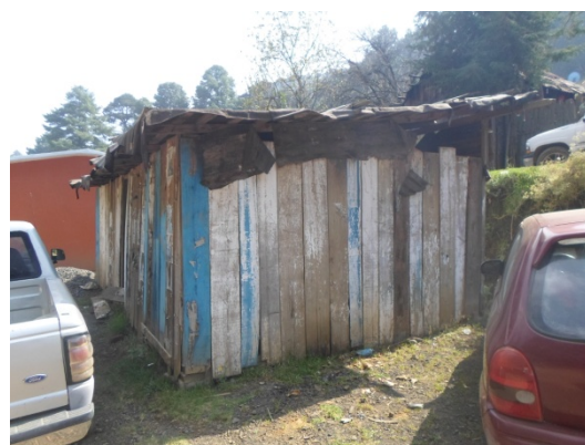
Figura 4. Aula antigua de madera.
