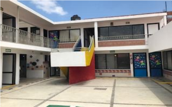
Vista posterior del edificio
