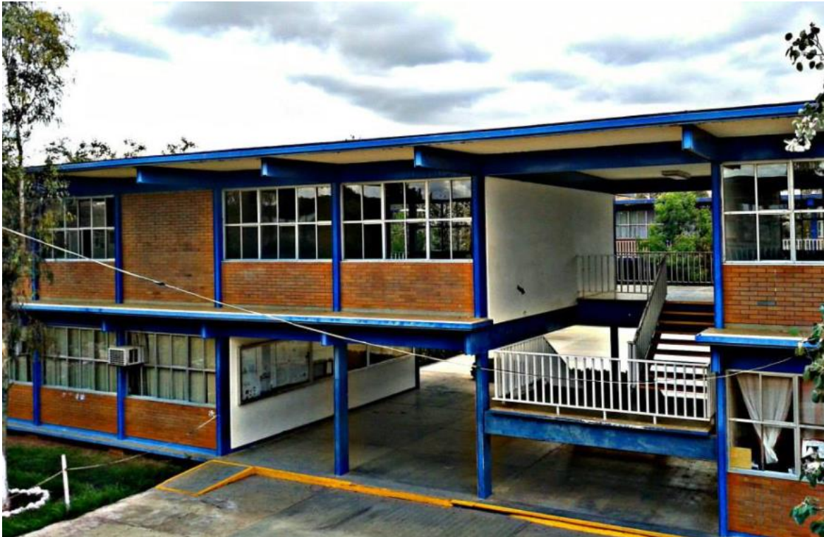
Figura 11. Instalaciones del CETis 113
