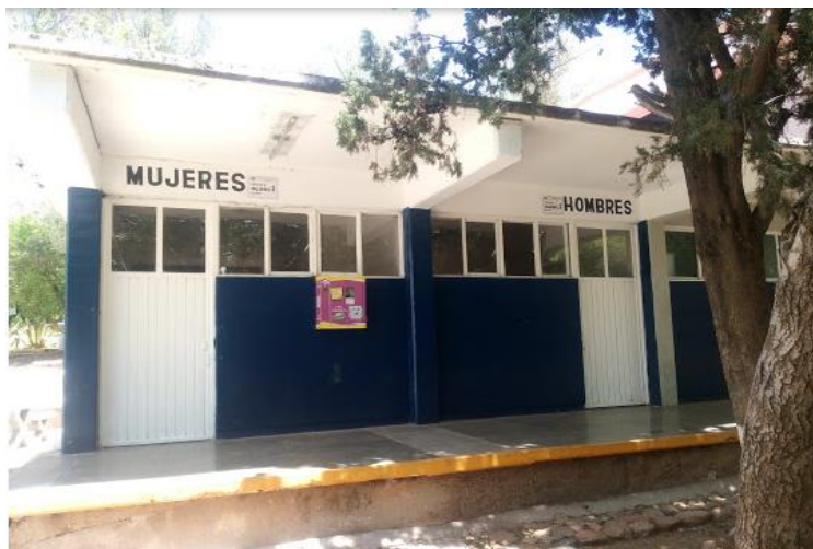
Imagen 7. Módulo de baños sanitarios
