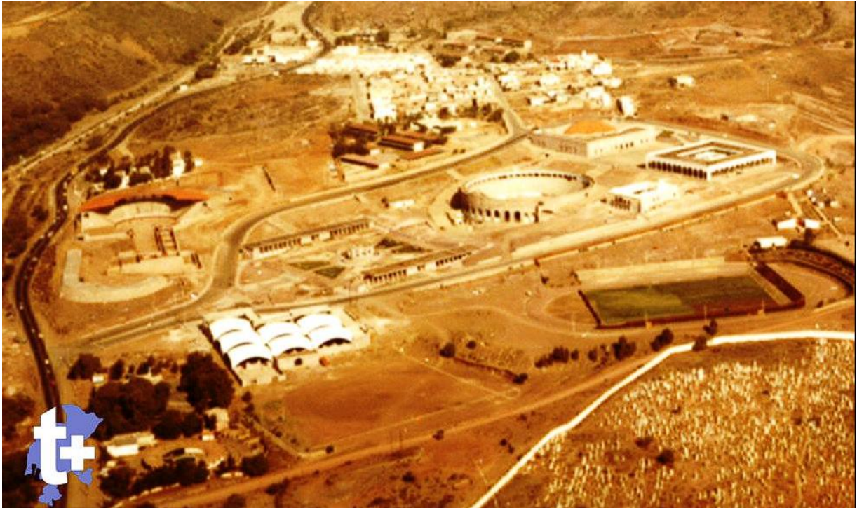
Fotografía 5. Imagen aérea de las instalaciones de la feria de Zacatecas, 1980
