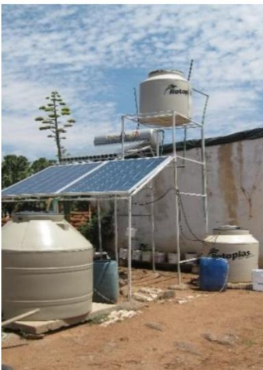
Figura 1. Estructura de soporte, paneles solares, calentador de agua solar y tinacos.
