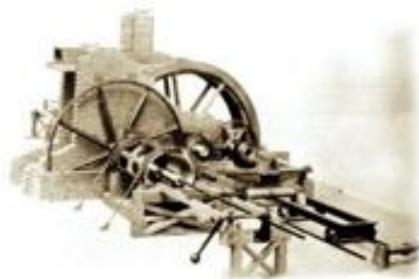
Figura 1.1 Mandrinadora de J. Wilkinson accionada por rueda hidráulica, fabricada en 1775 por encargo de James Watt.
