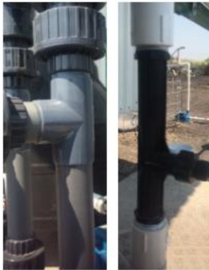
Figura 3.5 Inyector Venturi utilizado
