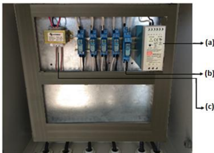
Figura 4.5 Componentes del módulo de potencia
