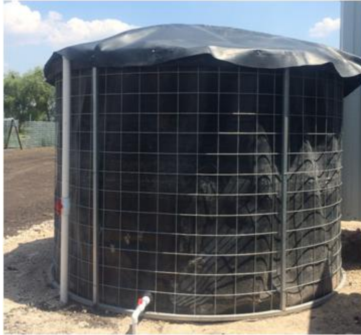
Figura 3.1 Depósito de agua utilizado como suministro del cabezal de riego
