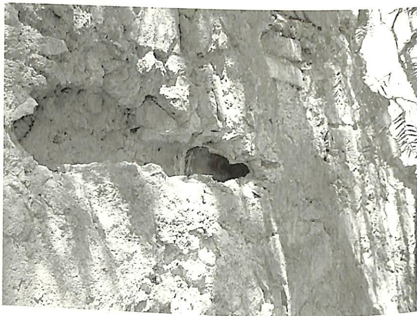
Tubería de barro para conducción de agua en Bernárdez.
