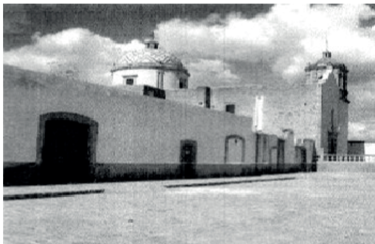
Imagen 3. Lo que queda actualmente del casco de la hacienda El Maguey (capilla orientada al patio principal), localidad perteneciente al municipio de Zacatecas. Fuente: Colección particular.
