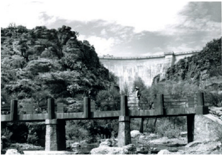
Imagen 2: El dique sobre el cauce del río Santiago, San José de Gracia, Aguascalientes. Fuente: Archivo Histórico del Agua, Aprovechamientos Superficiales, caja 515, expediente 14693.
