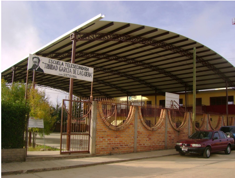
Figura 8. Fachada principal y entrada de la escuela.
