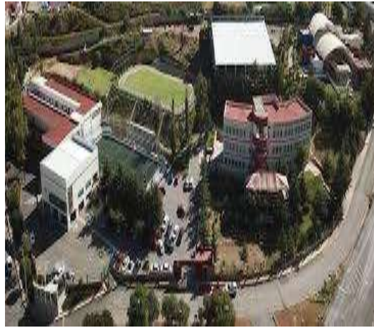
Figura 2. Panorámica aérea del IEZ
