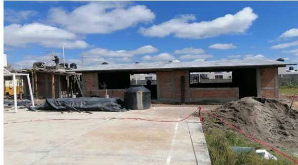
Imagen 2. Construcción de dos aulas
