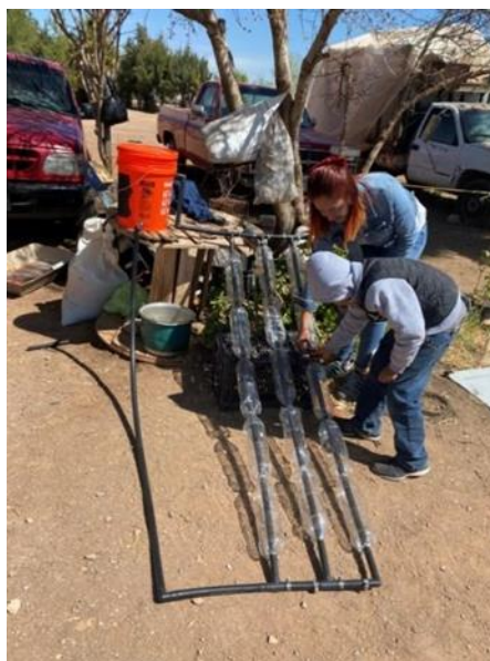
Imagen 12. Colaboración en la construcción del boiler solar
