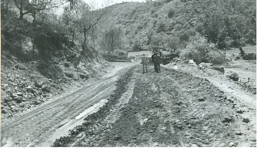
Figura 4. En 1975 se hizo la ampliación de la calle 2 de Abril, para facilitar el acceso al sitio arqueológico de Cuahilama. Los terrenos fueron donados por particulares. (Archivo Histórico de Xochimilco).
