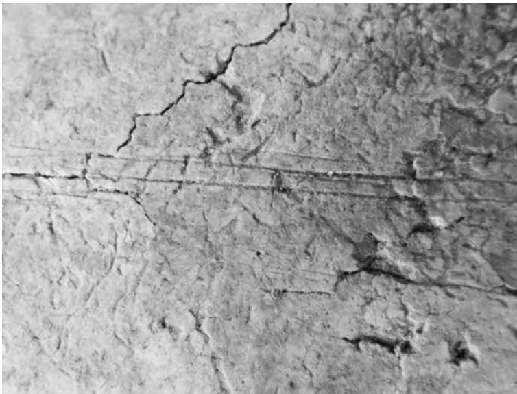
FIGURA 3. DETALLE DE HUELLAS DE CORTE
