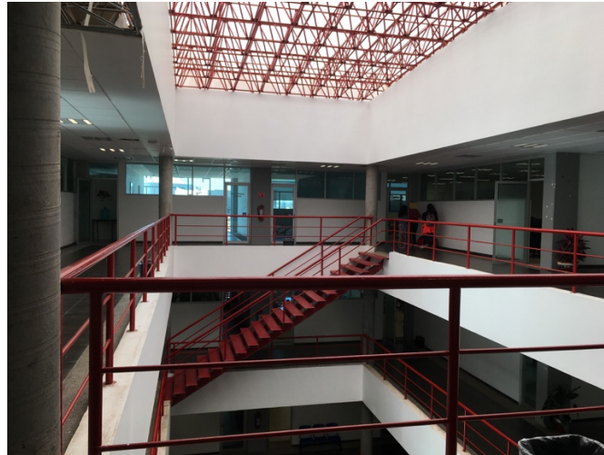
Imagen 6: Vista interior del edificio de la LILEX
