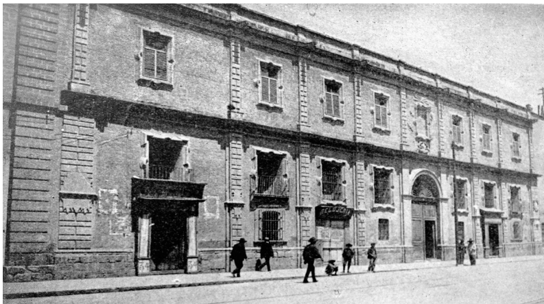
Fachada de san Andrés de México antes de su demolición. El Mundo Ilustrado, 1902. Imagen cortesía de la Biblioteca "Miguel Lerdo de Tejada" de la SHCP.
